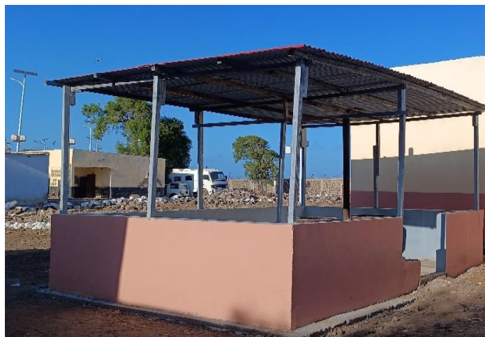
La cuisine réhabilitée pour les détenus femmes.
