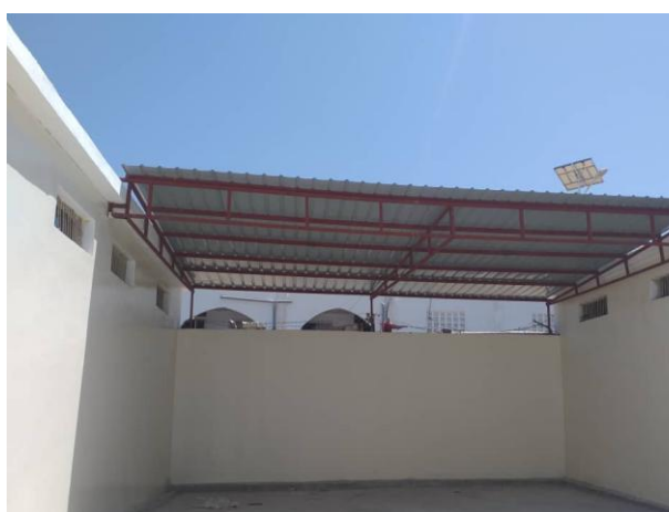
Nouveau toit ombrageant une partie de l'espace extérieur réservé aux femmes.
