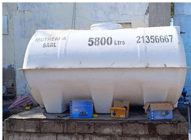
Installation et mise en service d'un réservoir d'eau (5 800 L)
