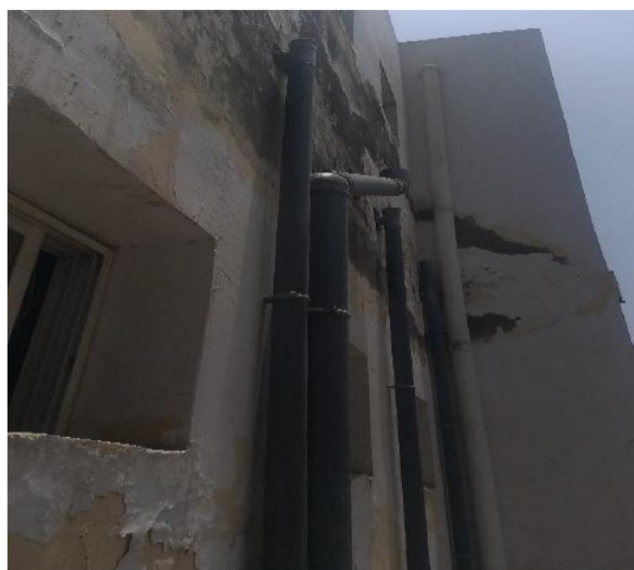
Installation d'une nouvelle canalisation
