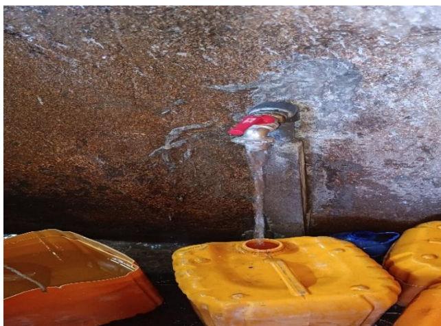
Installation de bornes-fontaines et de robinets
